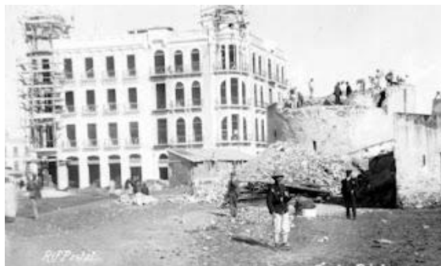
(A) Desmantelamiento de la torre de Santa Bárbara
